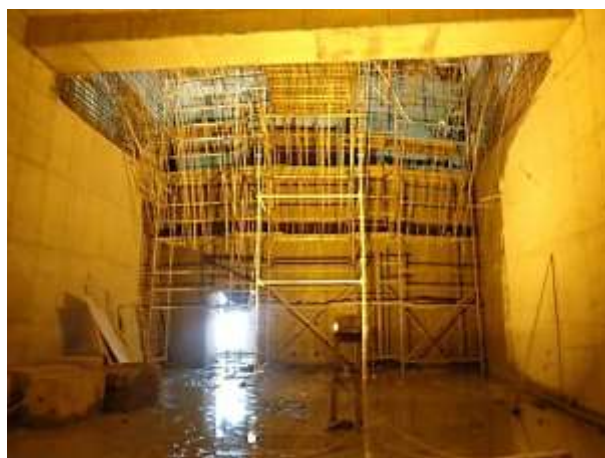
Interligação com a Linha 5 Lilás. Início da quebra da parede do poço.
