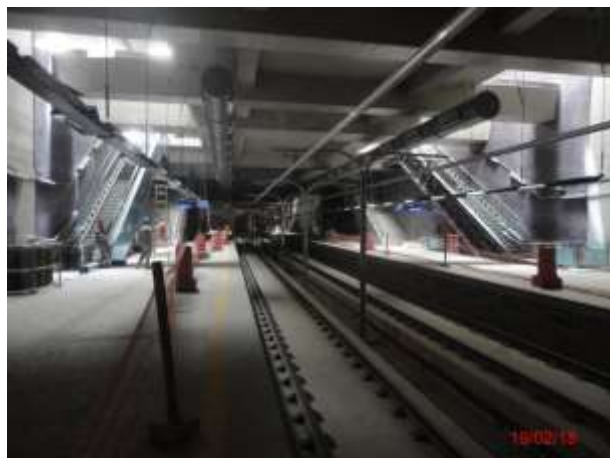
Plataformas: Instalação das escadas rolantes
