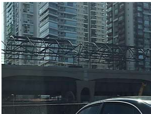
Montagem da estrutura e cobertura metálica.
