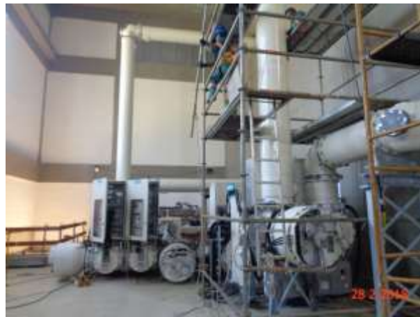
Montagem da GIS (Subestação Isolada a Gás).
