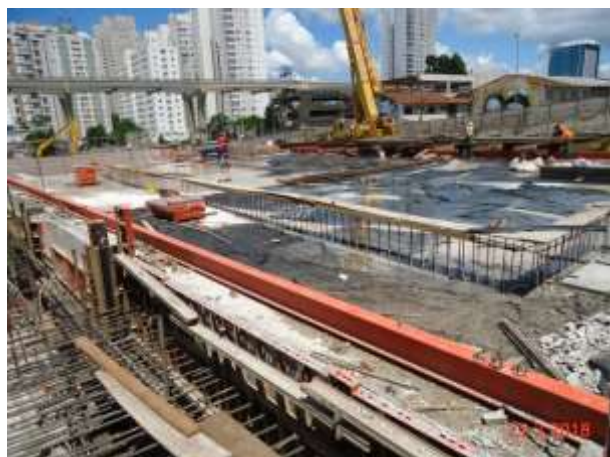
Corpo da estação – Poço 3: Concretagem da laje de cobertura
