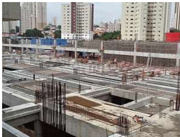
Execução de pilares, vigas e lajes.
