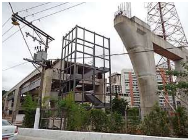
Montagem da estrutura metálica.
